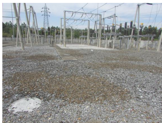
图 1-4 站内地面硬化
