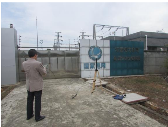
图 1-1 现有虬津 110kV 变电站
