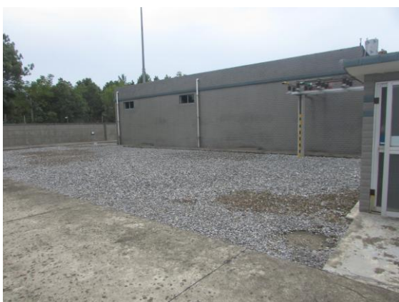
图 1-3 扩建 2 号主变场地现状
